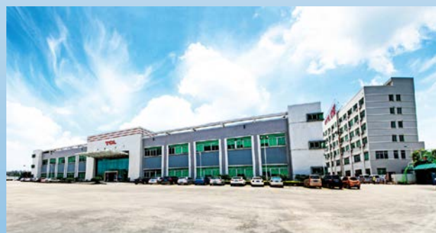
Jiujiang Base (2 εκ. σετ κλιματιστικών)
